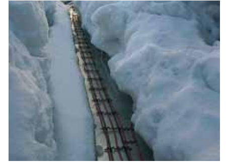
Déneigement de chéneaux
