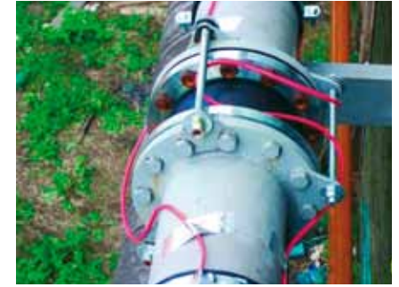
Maintien en température des tuyauteries
