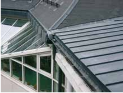
Déneigement de toitures
