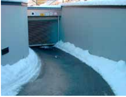
Déneigement entrées de garage
