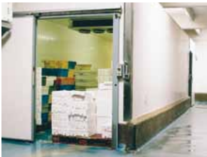
Protection des seuils de chambres froides
